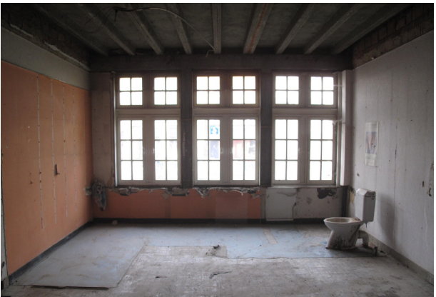
deel van Planet Parfum onder de appartementen (nr. 49) voor de verbouwing
