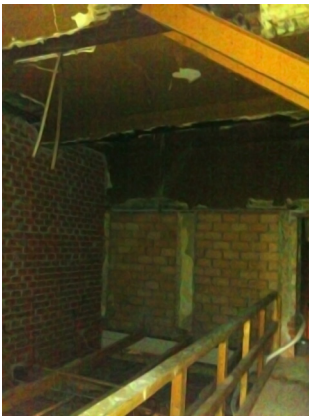
loopbrug over het vals plafond
