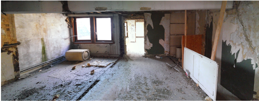
ruimtes op het tweede verdiep trekken licht via het binnengebied
